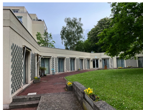
Bâtiment pouvant faire l'objet d'une surélévation
