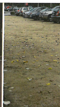
Trottoir en sable stabilisé
