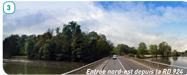
Entrée nord-est depuis la RD 924
