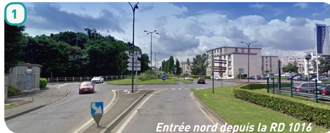
Entrée nord depuis la RD 1016
