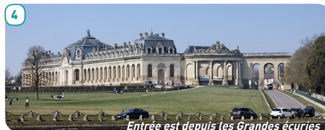
Entrée est depuis les Grandes écuries
