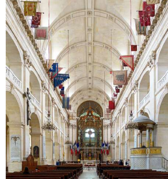
Église Saint-Louis des Invalides à Paris, la nef et la voûte
