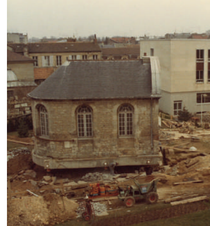
Déplacement de la chapelle Saint-Laurent, Fondation Condé, 1982, Chantilly, © Fondation Condé.
